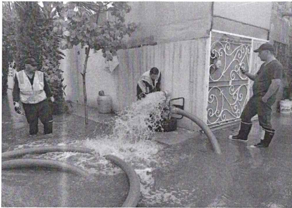
Trabajan en desagüe de alcantarillas
